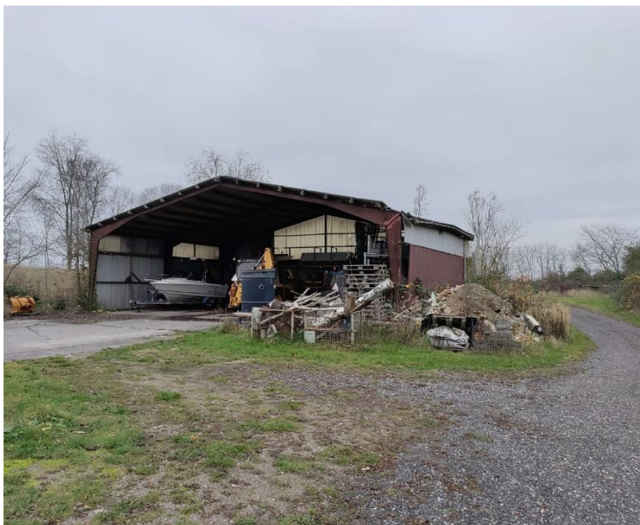
Figur 2 - Foto af bygning 16
